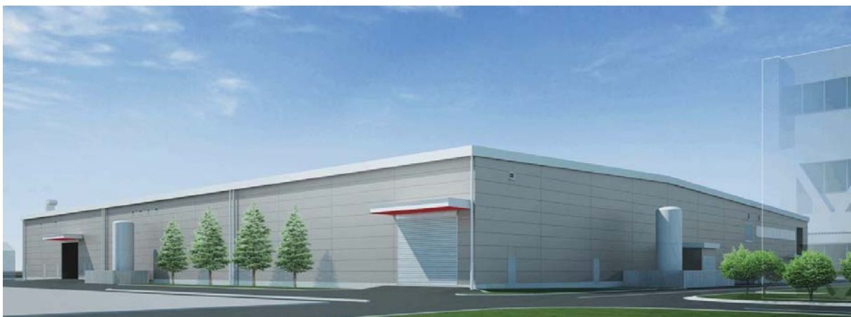
Aperçu de la nouvelle installation à la Sagami Factory
