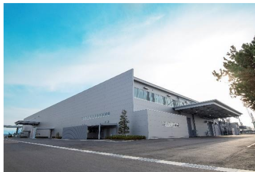
La nouvelle usine à automatisation intégrée destinée à la production d'interrupteurs et de disjoncteurs sous vide
