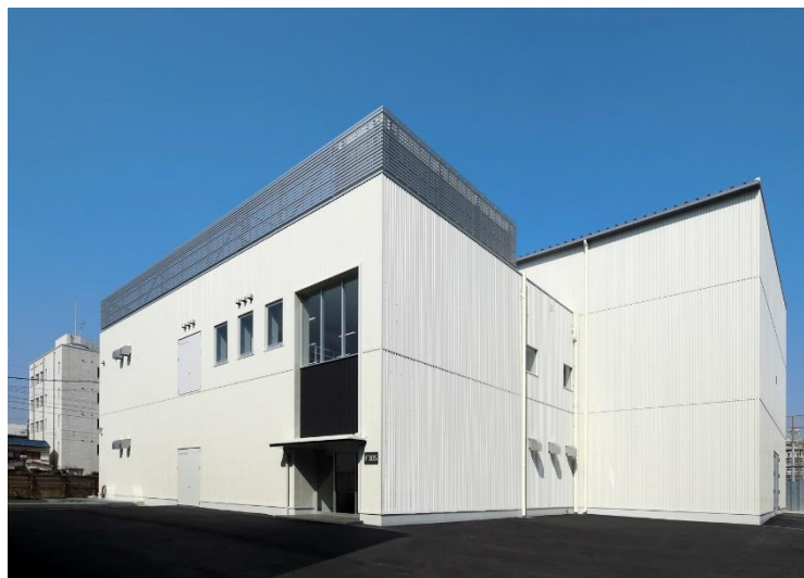
Nouvelle installation de vérification CCHT de Mitsubishi Electric
