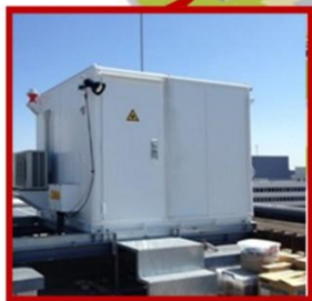
Système Lidar à effet Doppler terminal Détecter le cisaillement du vent dans des conditions de non-précipitation
