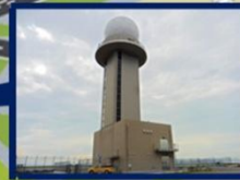
Radar météorologique à effet Doppler terminal Détecter le cisaillement du vent dans des conditions de précipitation
