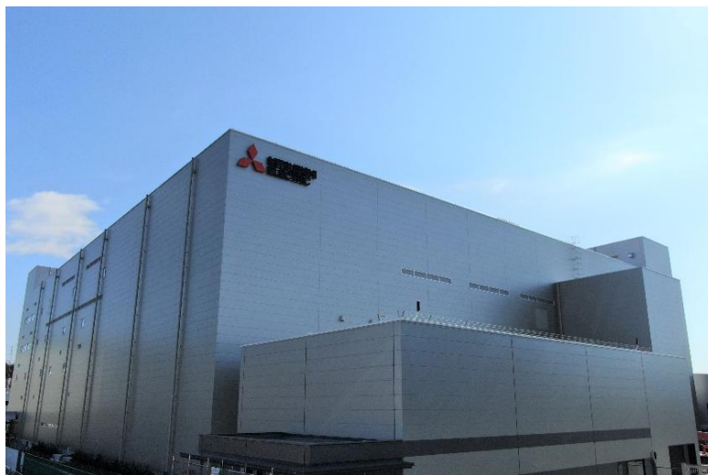
Nouvelle installation dans l'usine Kamakura Works
