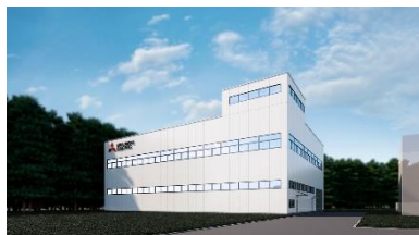
Usine de Koriyama
